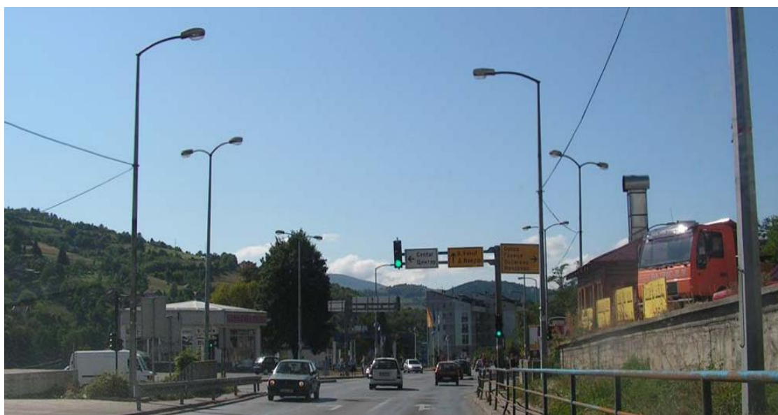
Slika 6 - Primjer dobro riješene rasvjete raskrsnice, Travnik [1]
